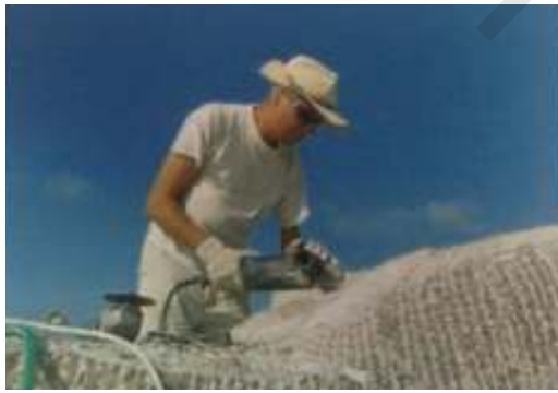
شكل (١١٥) استخدام الصاروخ الكهربى ( المصدر :
