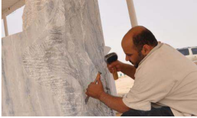
شكل (١٠٧) استخدام الازميل المبسط على الحجر ( المصدر : http://www.sabq.org/WSmfde )
