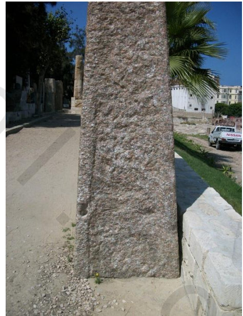
(صورة: ٣٥٥) توضح الجانب الأيمن من برج الصرح التقشر السطحى و كذلك الخشونة.
