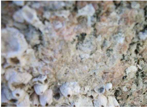
( صورة : ٣٩٧ أ-ب ) توضح عملية إزالة التكتلات الجيرية و القواقع البحرية ذو الالتصاق الشديد بالعضد الأيمن لبوابة فنار الإسكندرية الموجودة برصيف الميناء الشرقى بالطرق الميكانيكية بعد تطهيرها بالماء المقطر و التى يشير إليها السهم.
