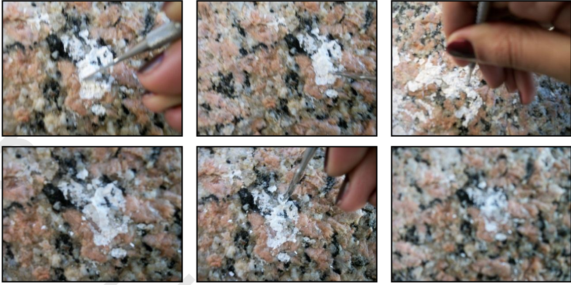
( لوحة : ٤٠٢ ) توضح مراحل عملية إزالة التكدسات الجيرية ذو الالتصاق الشديد بلعضد الأيمن لبوابة فنار الإسكندرية الموجودة برصيف الميناء الشرقى بالطرق الميكانيكية بعد تطريتها بالماء المقطر.
