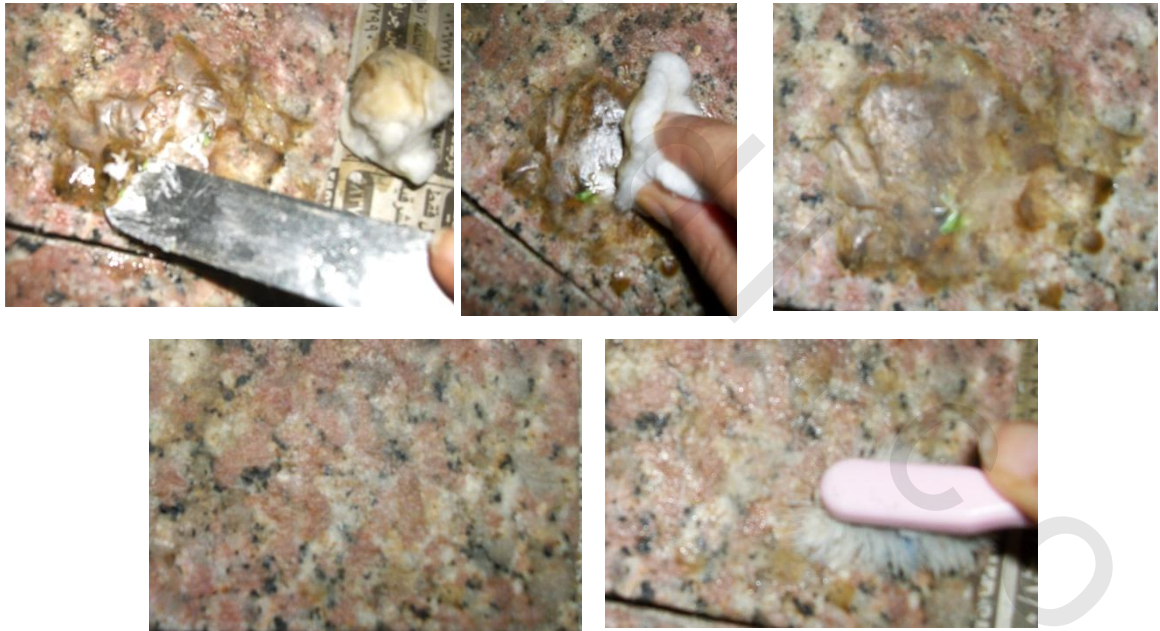
(لوحة: ٣٣٢ أ-ب-ج-د) توضح عملية إزالة آثار الشموع و التكلسات الشمعية باستخدام التربينتين النباتى المضاف إليه الكحول الإيثيلى بنسبة ١ : ٣ لإذابة التكلسات ثم إستخدام الطرق الميكانيكية يتببعها تنظيف التربينتين النباتى المضاف إليه الكحول الإيثيلى بنسبة ١ : ٣ ثم التنظيف بالكحول الأثيلى ثم عدة مرات بالماء المقطر.
