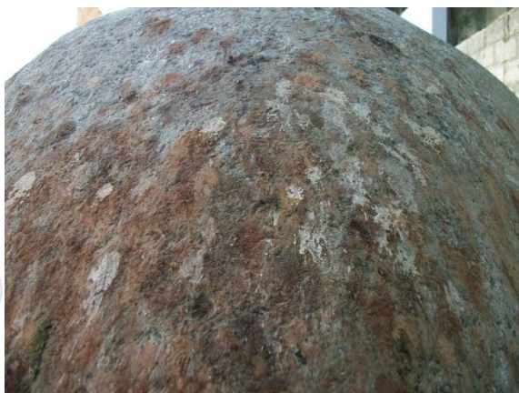
(صورة: ١٣٧٥ أ - ب ) توضح البقع البنية الناتجة عن النباتات و الأشجار و ثمار البلح بالإضافة للمونة الفاتحة اللون قبل عملية التنظيف.
