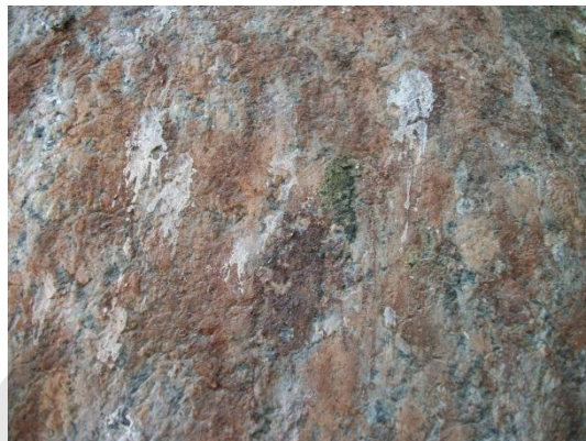
(صورة: ١٣٧٦ أ - ب ) توضح البقع البنية الناتجة عن النباتات و الأشجار و ثمار البلح بالإضافة للمونة الفاتحة اللون و فضلات الطيور المختلفة الألوان قبل عملية التنظيف.
