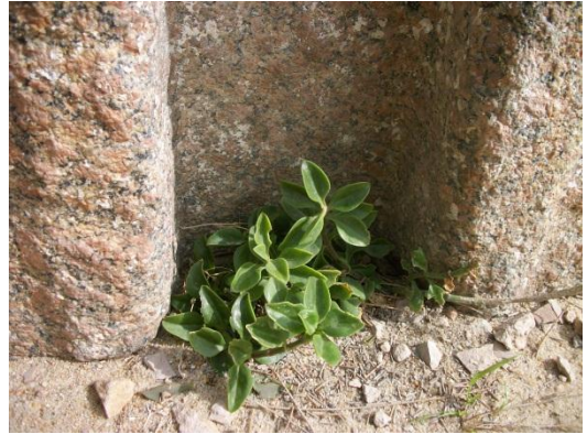
(صورة: ٣٦٣ أ - ب - ج - د ) توضح نمو النباتات أسفل القطعة حيث نلاحظ التصاقها و تجاورها بالآثر مما يودى إلى التلف البيولوجى.
