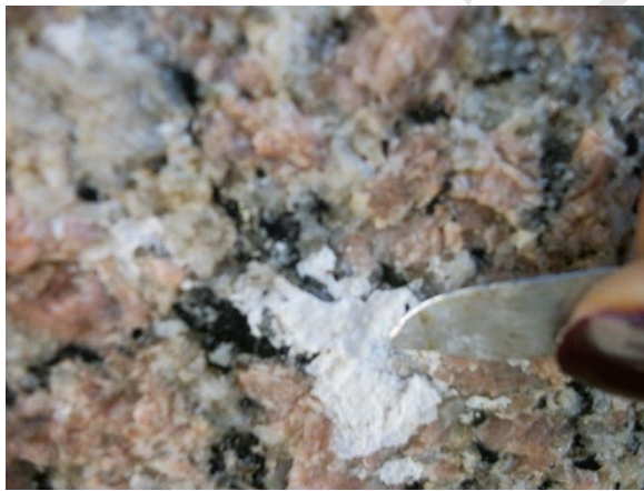
(صورة : ٤٠١) توضح عملية إزالة التكلسات الجبرية ذو الالتصاق الشديد بلعضد الأيمن لبوابة فنار الإسكندرية الموجودة برصيف الميناء الشرقى بالطرق الميكانيكية بعد تطريتها بالماء المقطر و التى يشير إليها السهم.
