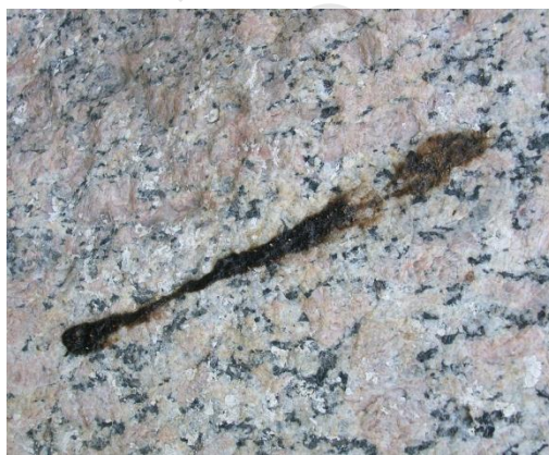
(صورة: ١٣٧٦ أ - ب ) توضح البقع البنية الناتجة عن النباتات و الأشجار و ثمار البلح بالإضافة للمونة الفاتحة اللون و فضلات الطيور المختلفة الألوان قبل عملية التنظيف.
