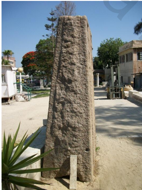
(صورة: ٣٥٦) توضح الجانب الأيسر من برج الصرح التقشر و التقشر السطحى الشديد و كذلك الخشونة كما نلاحظ أستناد أحد الألواح الحجرية على الأثر مما يعد نوعاً من الأتلاف البشرى.
