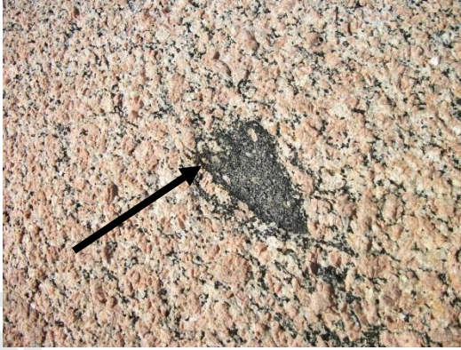
(صورة: ٣٩٣) توضح ظاهرة الخشونة في العضد الأيمن لبوابة فنار الإسكندرية الموجودة برصيف الميناء الشرقى.
