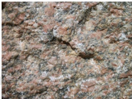
(صورة: ٣٥٨) ظاهرة التقشر السطحي في أحد أجزاء الجانب الأيسر من برج الصرح .
