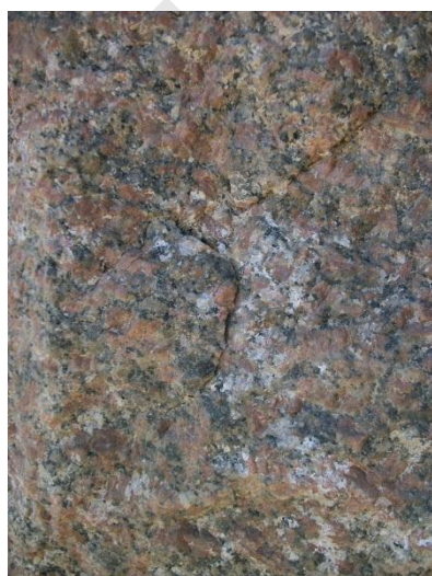
(صورة: ٣٦٠) ظاهرة التقشر السطحي في الجانب الأيمن من برج الصرح.
