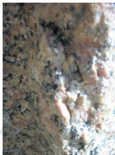
(صورة: ٣٥٩) ظاهرة التقشر السطحي الشديدة في منتصف الجانب الأمامي من برج الصرح .
