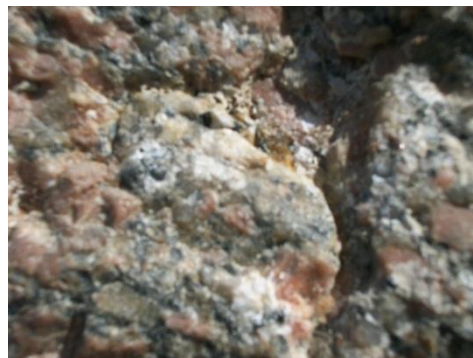
(صورة: ٣٥٧) ظاهرة التقشر الشديدة و العميقة في أحد أجزاء الجانب الأيسر من برج الصرح .
