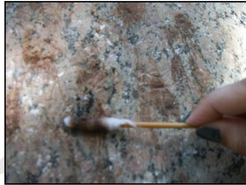
(صورة: ٣٨٦ أ و ب) توضح القيام بعملية إزالة البقع البنية و آثار المونة و فضلات الطيور بالماء المقطر و الأسيتون بنسبة ٥% مع الماء المقطر.
