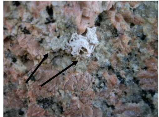
( صورة : ٣٩٨ ) يشير السهم الأزرق إلى أحد القواقع البحرية الملتصقة بالعضد الأيمن لبوابة فنار الإسكندرية الموجودة برصيف الميناء الشرقى قبل إزالتها، كما نرى إزالة التكلس الجبرى الذى يشير إليه السهم البرتقالى و الموجود إلى اليمين ويظهر قبل أزالته فى الصورة السفلى.
