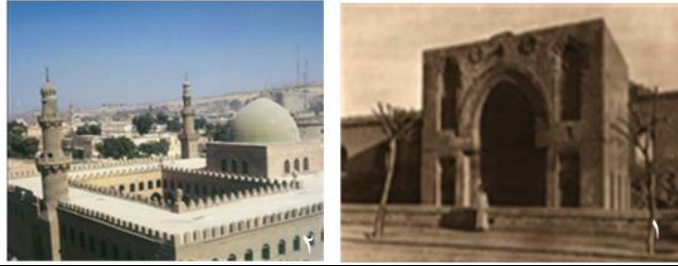
شكل (٧٧/١/٢): ١. خروج كتلة المدخل عن سمت الواجهة - مسجد الظاهر بيبرس - القاهرة: ٢. خروج كتلة المأذنة عن مسطح الواجهة بجامع الناصر محمد - القلعة - القاهرة.
