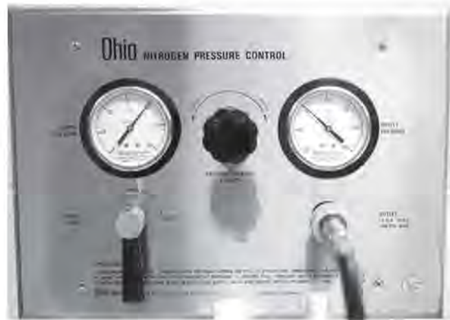
الشكل رقم (٨٩،٢). مآخذ جدارية بغرفة العمليات (OR) لغاز النيتروجين.
