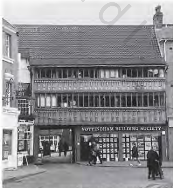
الشكل رقم (٩، ٤٨). مبنى مقر البلدية، نيوارك لكار يورك، Rehabilitation, Market Square, Newark.
