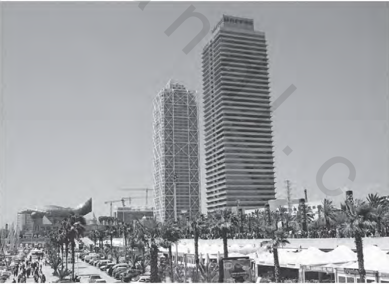
الشكل رقم (٩,٧٣). الميناء الأولمبي Olympic Harbour.
