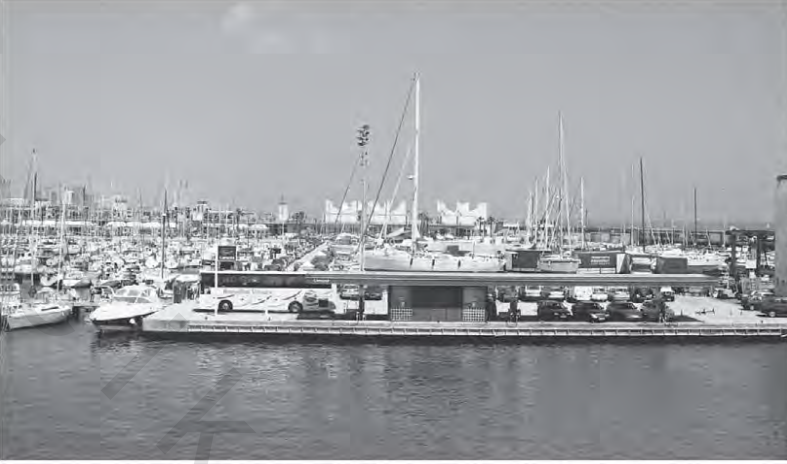
الشكل رقم (٩,٧٢). الميناء الأولمبي Olympic Harbour.
