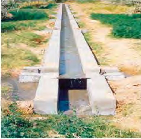
الشكل رقم (٢، ٩). قناة ري غير مبطنة وأخرى مبطنة لنقل مياه الري من المصدر إلى الحقل.
