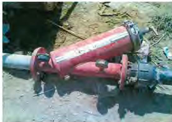
الشكل رقم (٤٣، ١٠). وجود مقياس ضغط قبل وبعد المرشح المنخلي.
