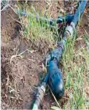
الشكل رقم (٢١، ١٠). المرشحات المنخلية في نظام الري بالتنقيط.
