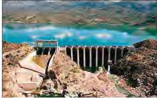
الشكل رقم (٢٨، ٢). سد تتجمع المياه خلفه.
