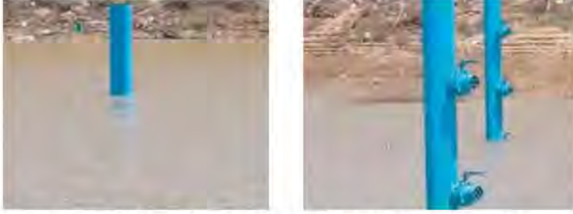
الشكل رقم (٣٢، ٢). تغذية المياه الجوفية باستخدام أنابيب التغذية الصناعية.
