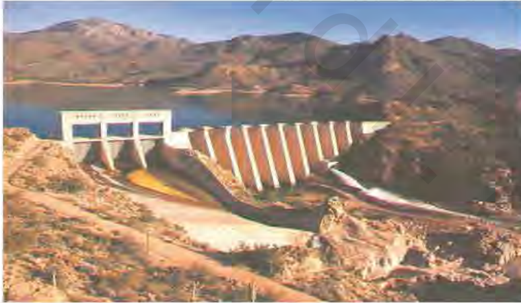
الشكل رقم (٦، ٣٨). سد خرساني ذو دعائم.
