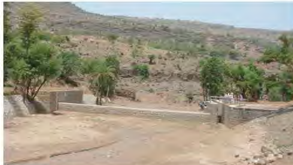
الشكل رقم (٦, ٢٠). سد مبني بالأحجار لحصد المياه في الوادي.
