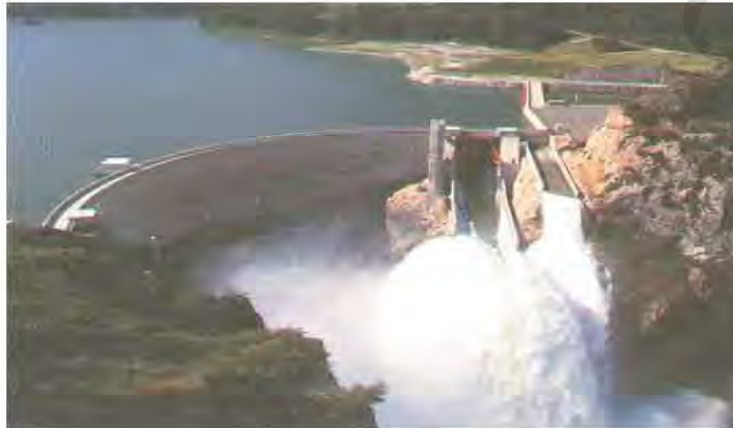
الشكل رقم (٦, ٣٧). سد خرساني مقوس.
