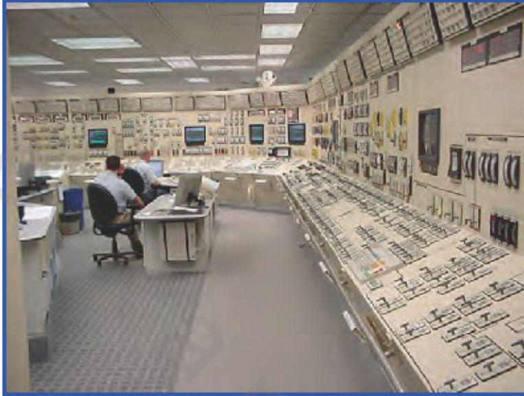
الشكل رقم (٢,١٠). غرفة التحكم في المفاعل [٣٦].
