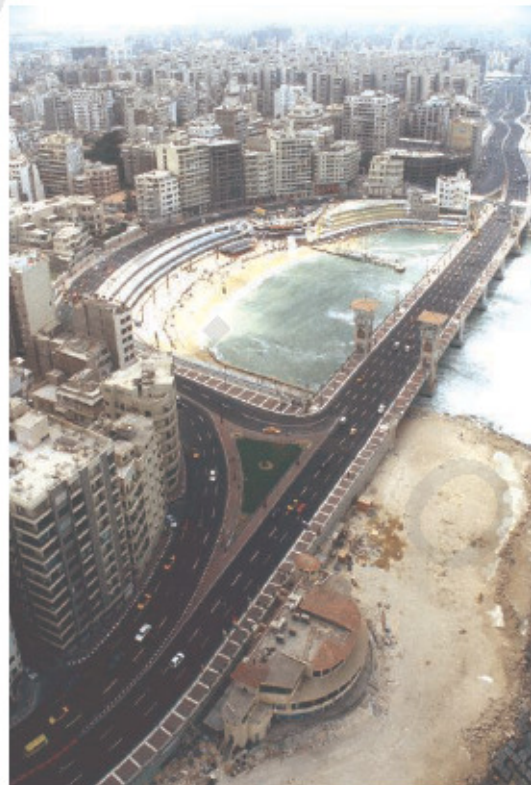
شكل (١٣٥) كوبرى سناتلى ( Stanley Bridge - Alexandria ) المصدر
