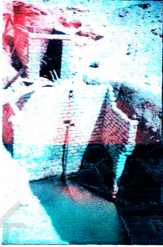
شكل رقم (٩) يوضح البئر السطحي على عمق ١٦ متراً
