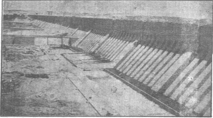
شكل رقم (٢ - ٣٢) سد خرساني حيث يستخدم الاسمنت البورتلاندى منخفض الحرارة
