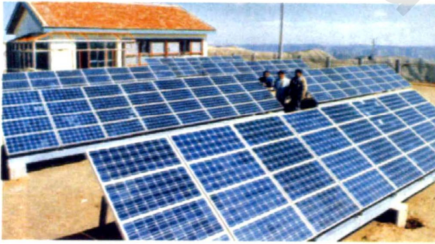
شكل ( ١٤ ) نظام شمسي متكامل لتغذية قرية صغيرة بالكهرباء .
