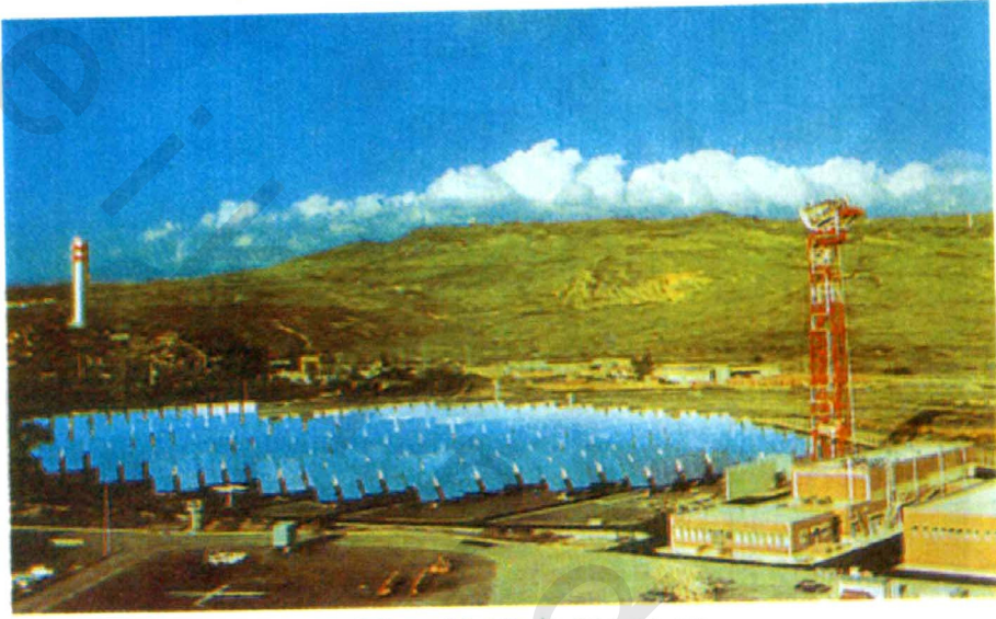
شكل ( ٧ ) نظام المستقبل الشمسى المركزى
