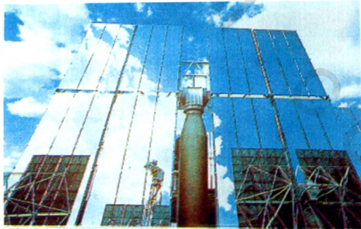
شكل ( ٧ ) نظام المستقبل الشمسى المركزى
