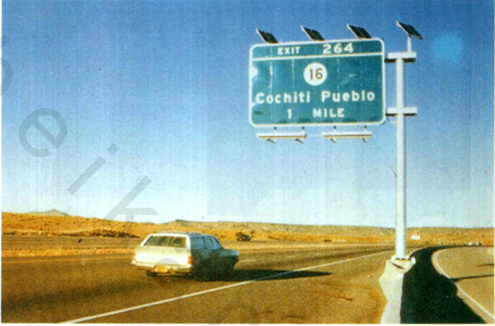
شكل ( ١٢ ) إضاءة العلامات الإرشادية للطرق بالطاقة الشمسية .
