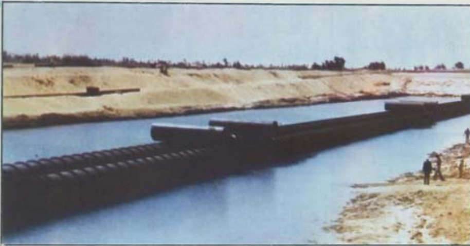
مواسير السحارة العملاقة أثناء عمليات التروم والنقل التي قامت بها شركة مساهمة الحيرة بعد تصنيها في ورشها الخاصة .
