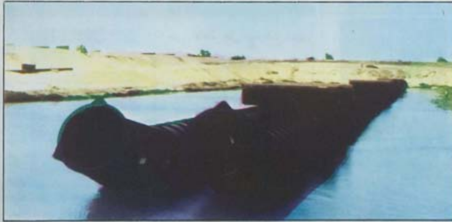
ويصل قطر المسورة إلى مترين وبطول ٥٠ مترا بما يسمح بمرور ملايين من الأمتار الكعبة من المياه العذبة إلى سيناء
