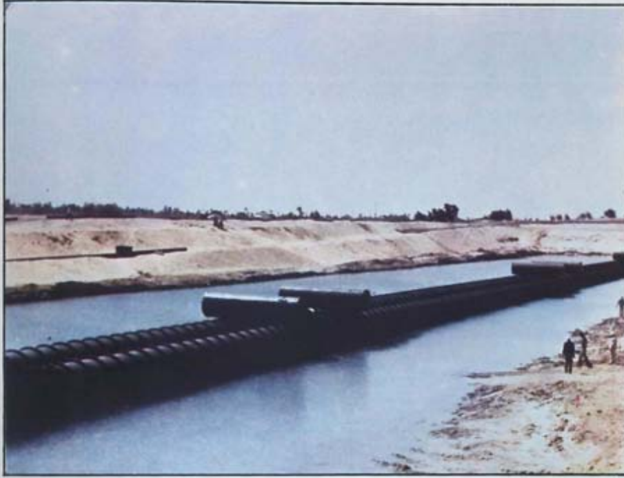
مواسم السحارة العملاقة أثناء عمليات التروم والفلل التي قامت بها شركة مساهمة البحيرة بعد تصنيها في ورشها الخاصة
