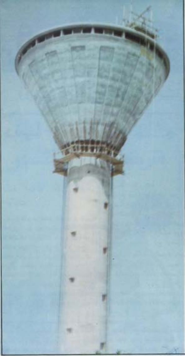
الحلة بعد رفعها إلى مكانها فوق جسم الخزان
