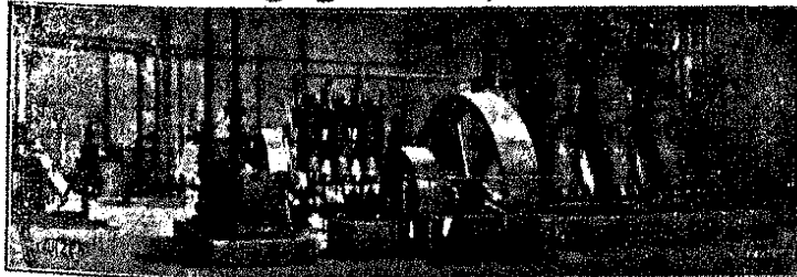
معمل ثلج بيورسميد يشغل بمكبس للشادر طرد سولزر ( ٦٠٠٠ و ٦٠٠٠٠ ) مبرد انكليزي بالساعة ) يدار بواسطة محركات طرد سولزر ديزل قوتها الاجالية ٢٤٠ حصانا
