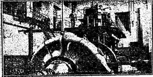
عملية ري وادي كوم امبو مشتملة على طلبية بمروحة طرز سرلزر مزدوجة رأساً بمحرك سولزر ديزل قوة ٣٠٠٠ حصانا
