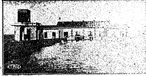
عملية طلبيات البصيري للصرف مشتملة على اربع طلبيات بمراوح طرز سولزر كل منها تدار بواسطة محرك سولزر ديزل قوة ١٤٠ حصانا
