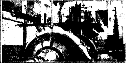
موتيرة ري وادي كوم اومبو مشتملة على طلمبة بخروطة طرز سولزر مزودة رأساً بمحرك سولزر ديزل قوة ٣٠٠٠ حصاناً
