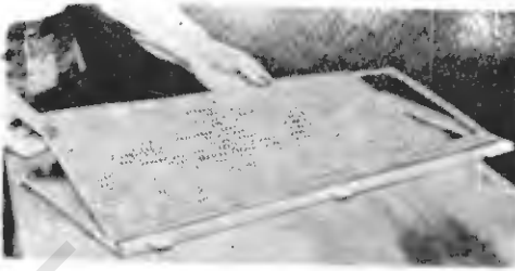
رسم رقم ( ٢ - ٧ ) مرشحات الهواء من النوع الدائم الاستعمال والمصنوعة من شبك الألومنيوم . وتبين هذه الصورة طريقة تركيبها في البرواز الخاص بها .
