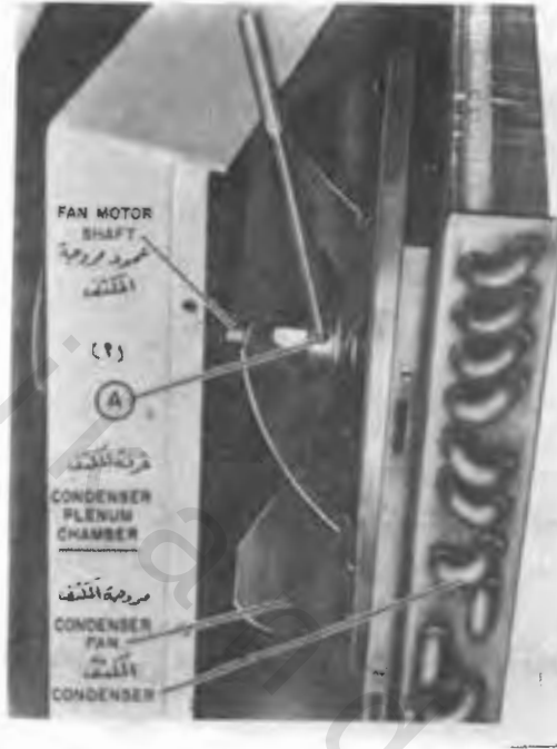
رسم رقم (٧ - ٤٣) - طريقة حل مروحة مكثف جهاز تكييف هواء الغرفة
