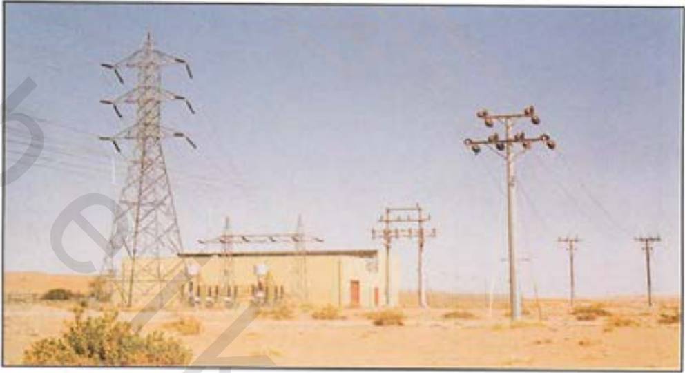
إحدى محطات التحويل الكهربائية
