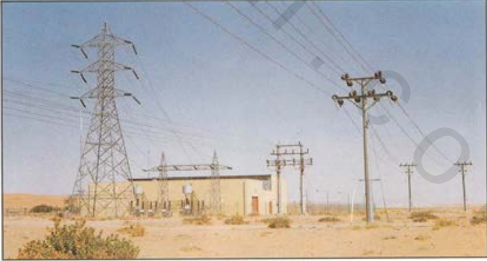
خطوط نقل الطاقة الكهربائية
