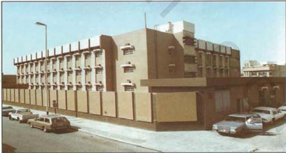
إحدى مدارس البنات
