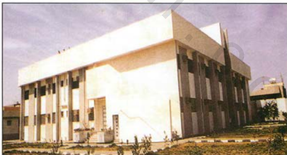
إحدى مدارس البنات
