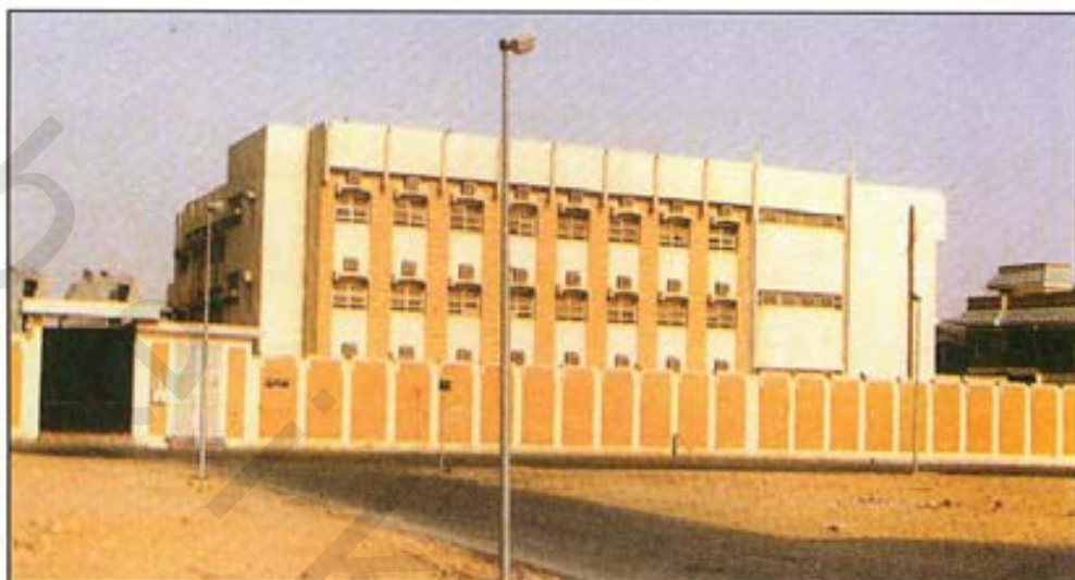
إحدى مدارس البنات
