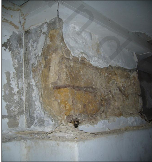
(لوحة ٩) المداميك الحجرية في الحوائط الحاملة بالبدروم (آثار الرطوبة)
