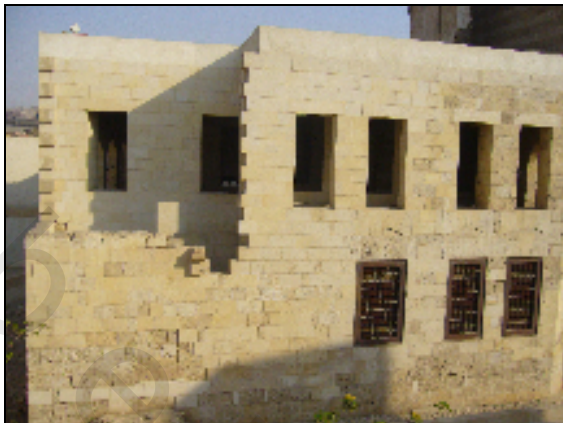
لوحة ١٤ - الواجهة الشمالية الشرقية
