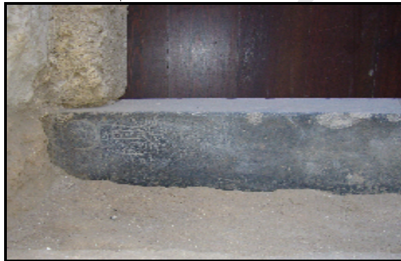
لوحة ٧ - عتبة سفلى بازلت أسود بين مداميك مدخل الرباط
